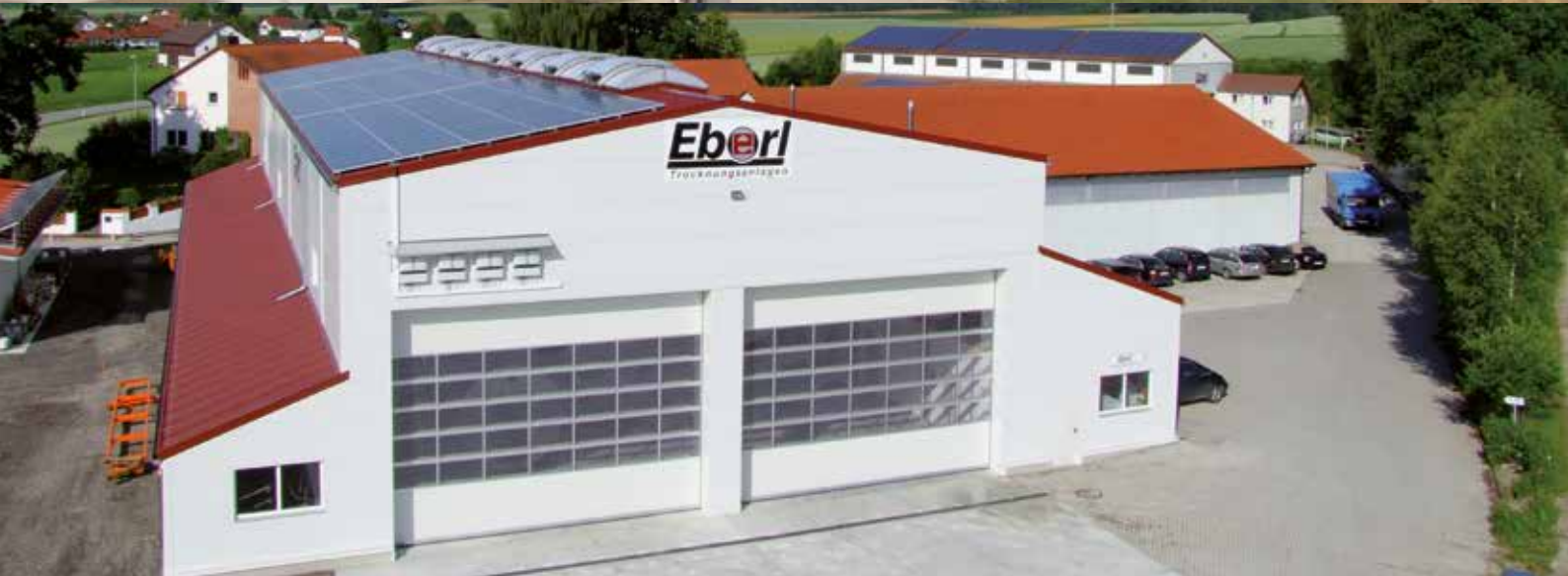
Siedziba firmy EBERL Trocknungsanlagen w Bodenkirchen (Bawaria)
