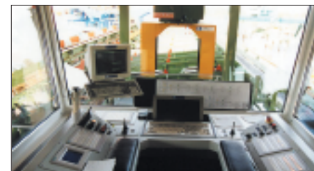
Ergonomicznie zaprojektowane centrum kontrolne do kierowania zakładem
