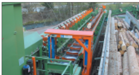
Transporter poprzeczny z wbudowanym skanerem i urządzeniem korującym. Linia działa z wykorzystaniem podajników sortujących kłody.
