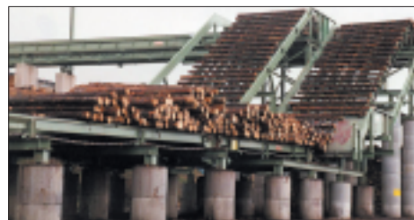
Podwójna linia zasilania do linii rębaków dużych wydajności. Podawanie do 40 kłód na minutę
